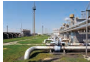
炼油厂和管道
