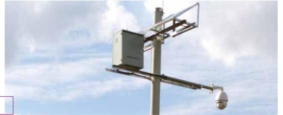
镇有一定人口居住的村落中，安装于住户楼房或村委会楼房之上，便于维护设备；自动水位站主要部署在乡镇的主要河道上，配备水位传感器、雨量传感器，观测水位与雨量；在一些重要河道上、人群聚集较多的地方，建置视频监测站，结合水位、视频及定时抓拍的一些图片，确定真实的水位。此外，还建了 62 个简易雨量站，28 个简易水位站，这些站点只作预警报警，不作远程数据的传输。例如，某一村民家装了简易雨量站，一旦雨量达到设定值，雨量报警器便发出声音，提醒当前以此村民家为中心的区域，雨量已经超过设定的预警值，请大家注意。
